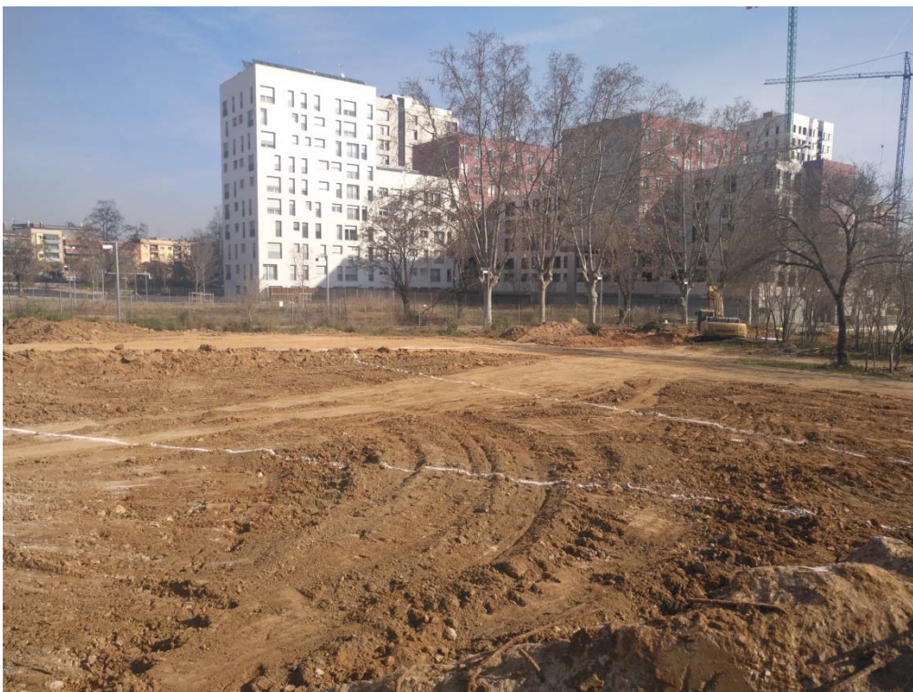
Foto 33: Replanteig de la rasa del col·lector direcció E
