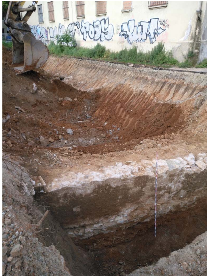
Foto 21: Alçat N UE 12 amb edifici actual al costat
