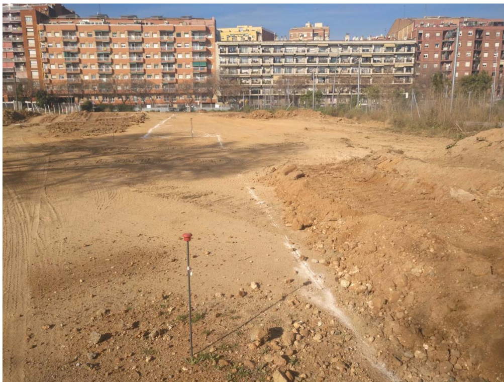
Foto 31: Replanteig de la rasa del col·lector paral·lela al carrer de Palomar
