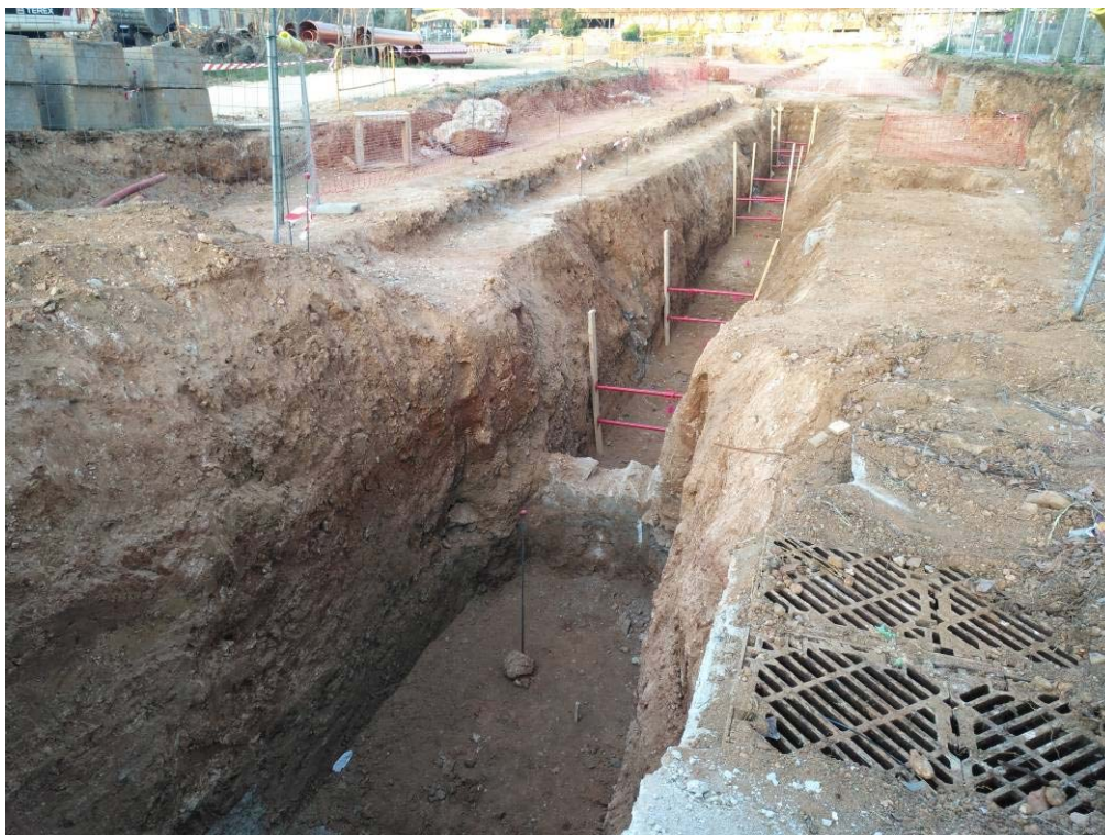
Foto 3: Localització abans de la col·locació de l'apuntament
