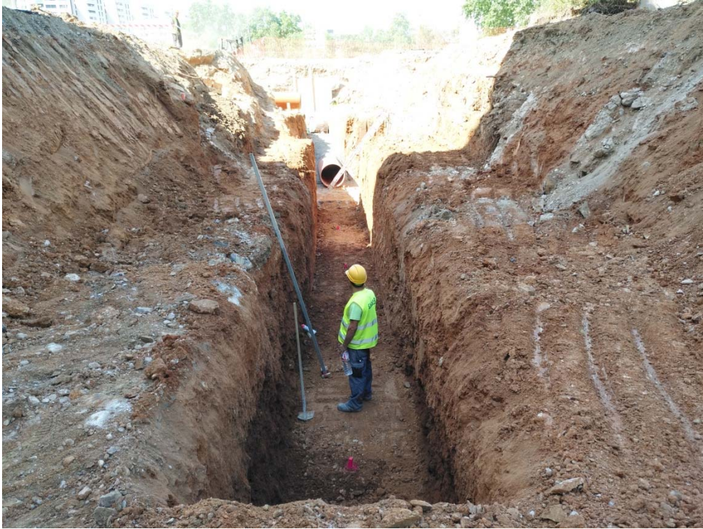
Foto 55: Rasa perpendicular al carrer de Palomar, un cop eliminat el mur UE 12
