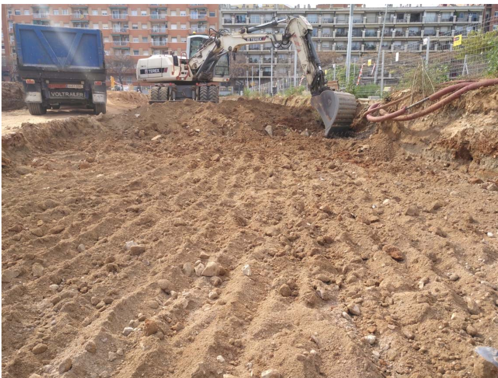
Foto 42: Rasa al costat del carrer de Víctor Colomer
