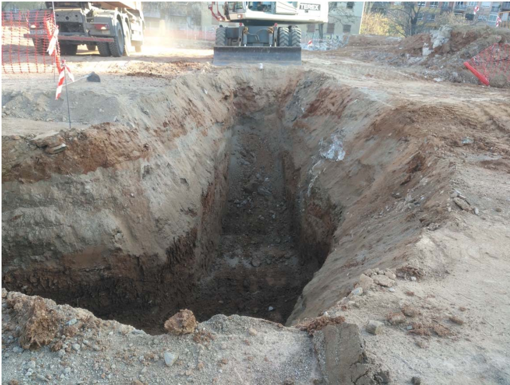
Foto 47: Rasa a la zona central del solar
