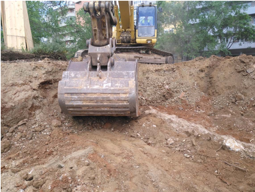
Foto 11: Delimitació mecànica del mur UE 12
