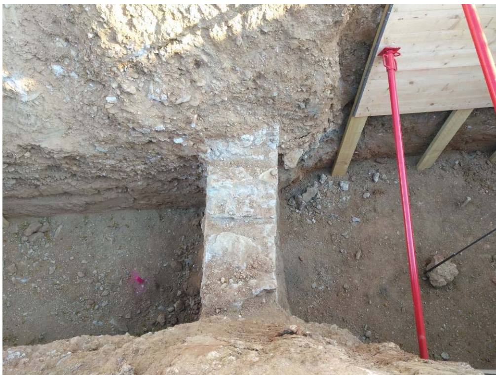
Foto 4: Detall del mur després de l'apuntament
