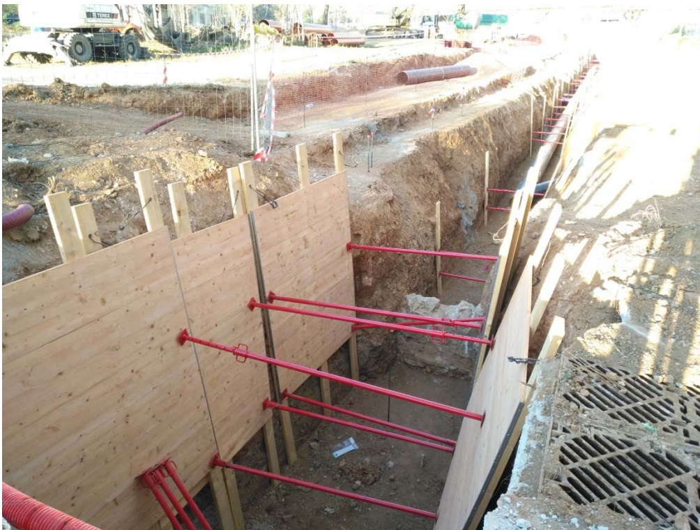
Foto 48: Rasa al costat del carrer de Víctor Colomer
