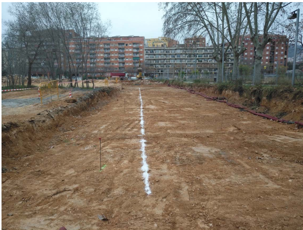
Foto 39: Rasa al costat del carrer de Víctor Colomer
