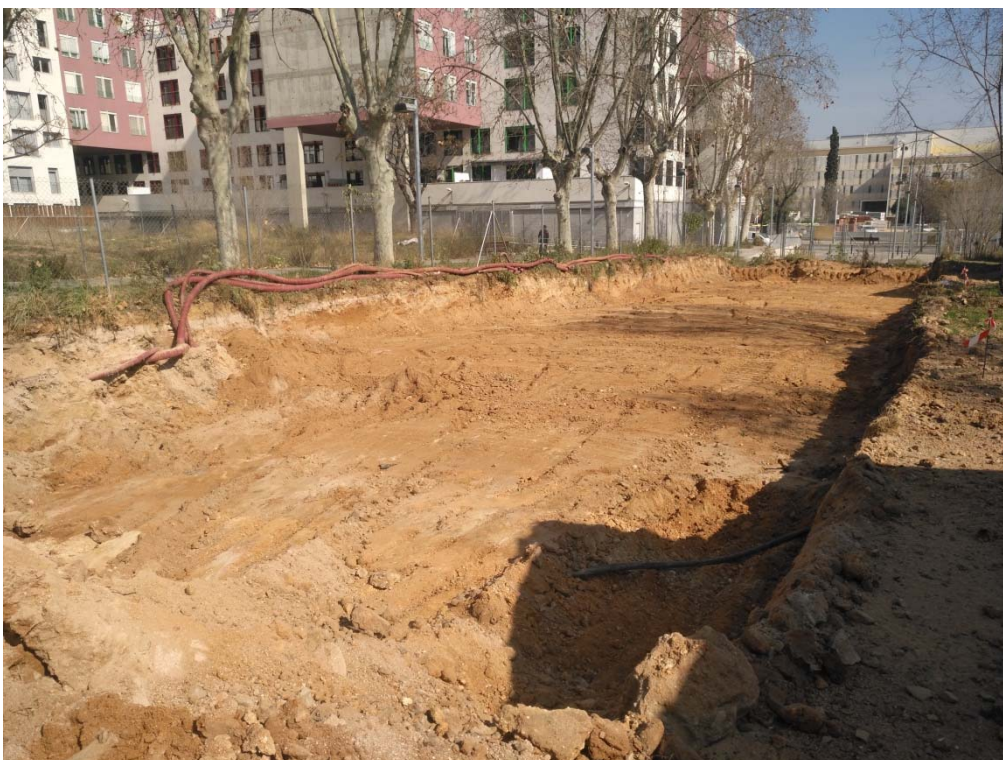
Foto 34: Rasa al costat del carrer de Víctor Colomer
