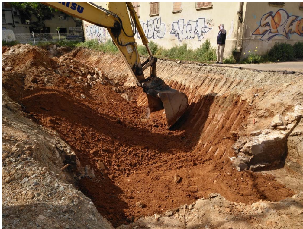
Foto 23: Excavació argiles UE 18 en la rasa del col·lector i restes del mur UE 12
