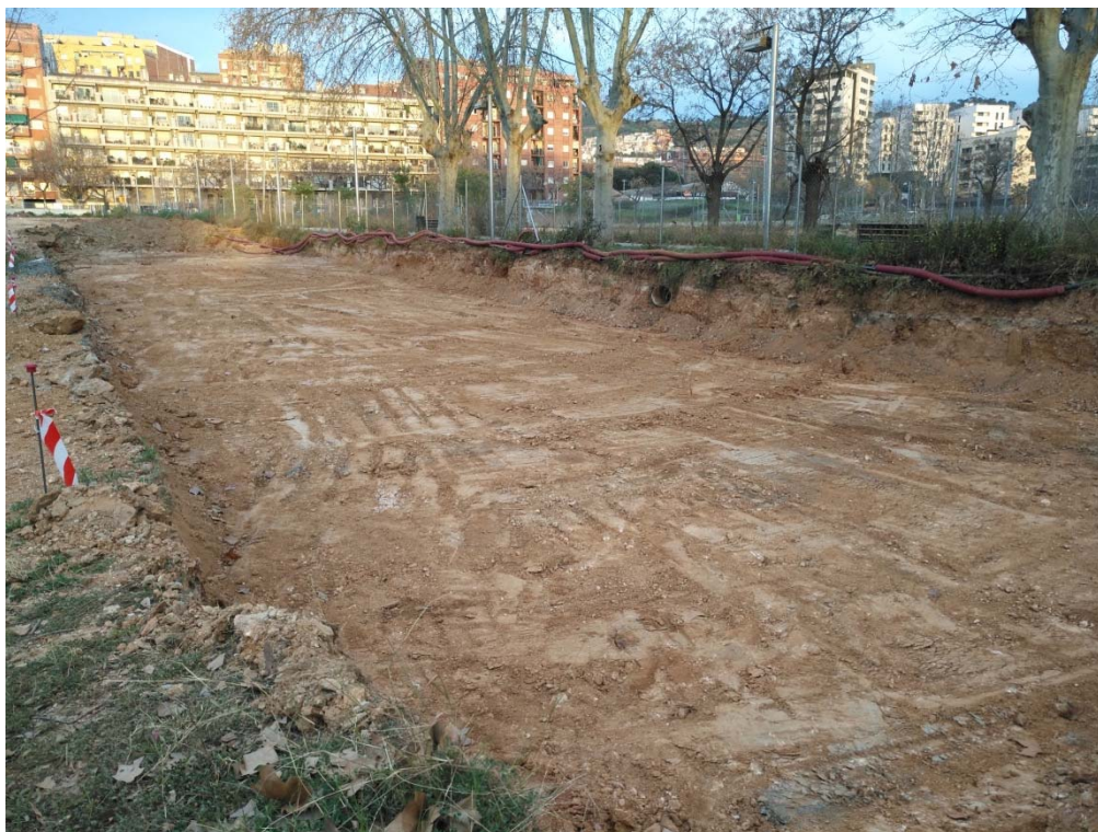
Foto 35: Rasa al costat del carrer de Víctor Colomer
