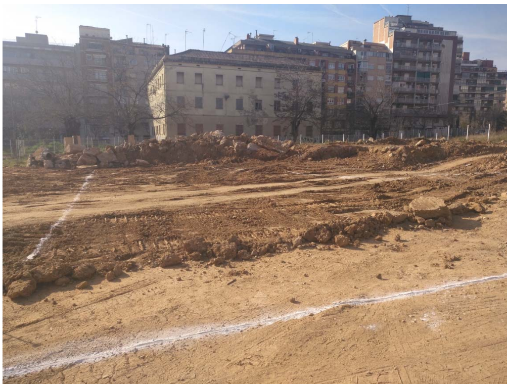
Foto 32: Replanteig de la rasa del col·lector direcció S
