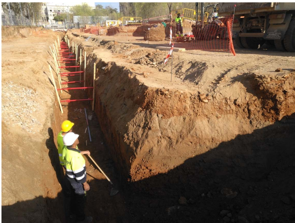
Foto 46: Rasa al costat del carrer de Víctor Colomer
