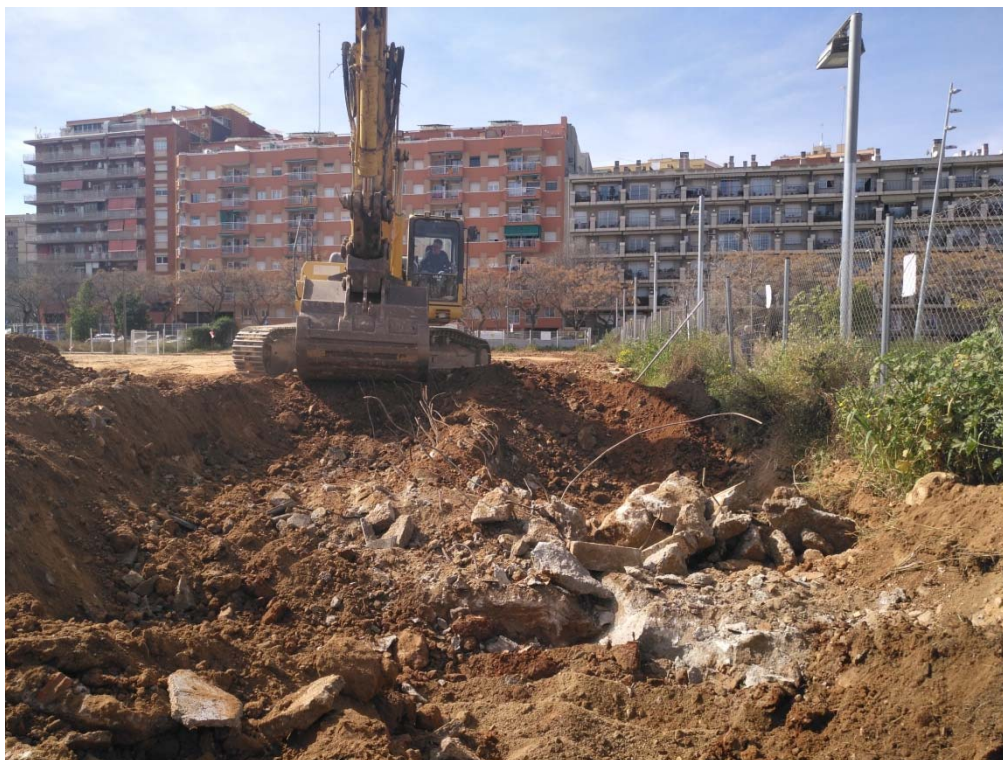
Foto 37: Extracció de part de les estructures de formigó
