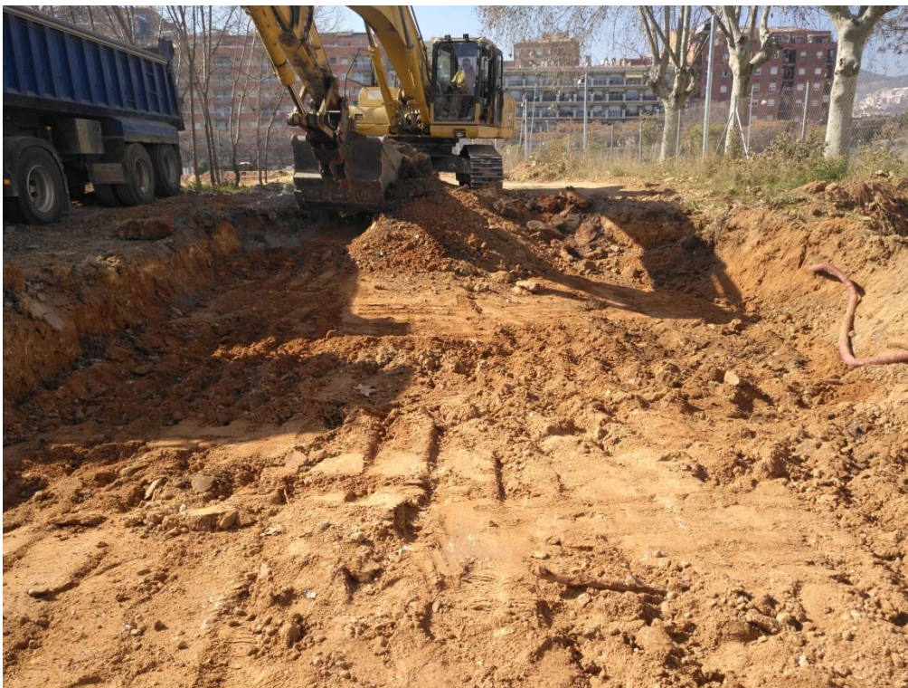
Foto 30: Excavació rasa de col·lector al costat del carrer de Víctor Colomer
